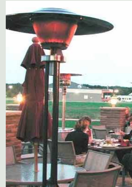
Grijanje na otvorenom prostoru se zasniva na zračenju
