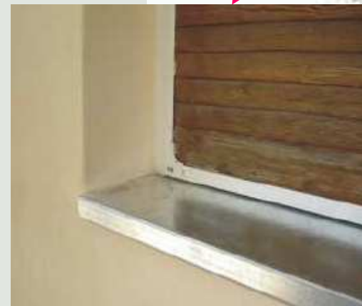
Produženje korišćenjem metalnih djelova
