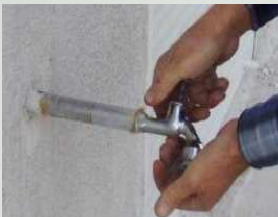
Produživanje vodovodnih cijevi
