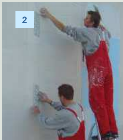
Postavljanje fiberglass mrežice
