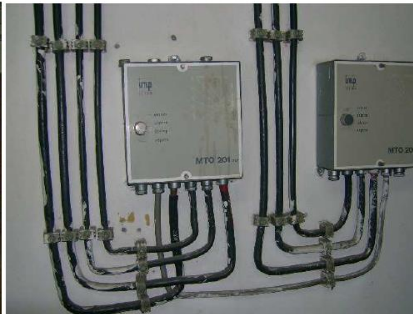
sl.3.7.b) automatska regulacija kotlova.
