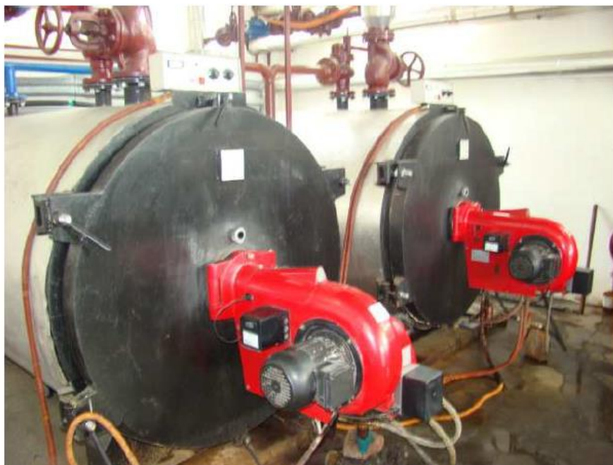
Slika 3.6. Toplovodni kotlovi
