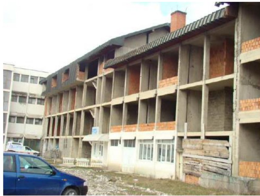
Slika 3.4. Objekat urgentnog centra (br.9), u izgradnji.
