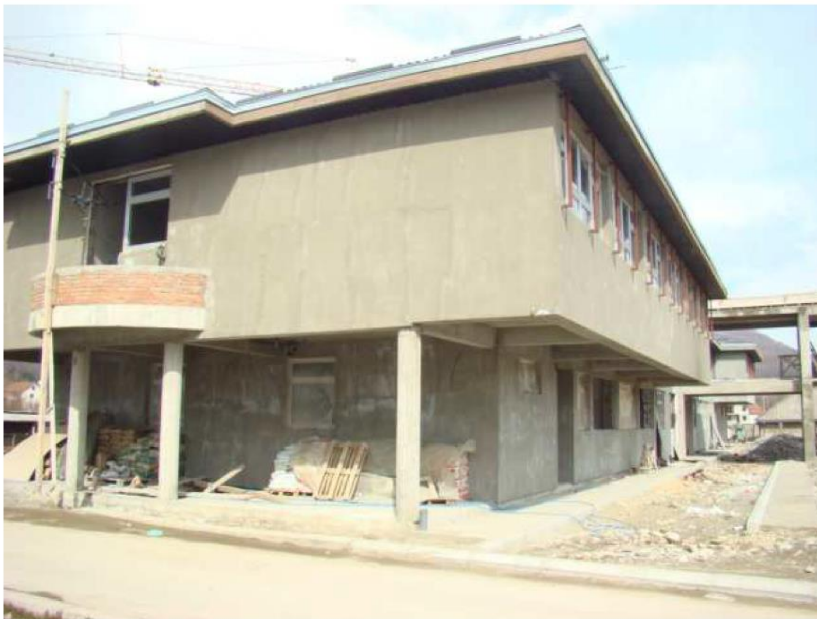
Slika 3.3. Objekat aneksa bolnice (br.5), u izgradnji.
