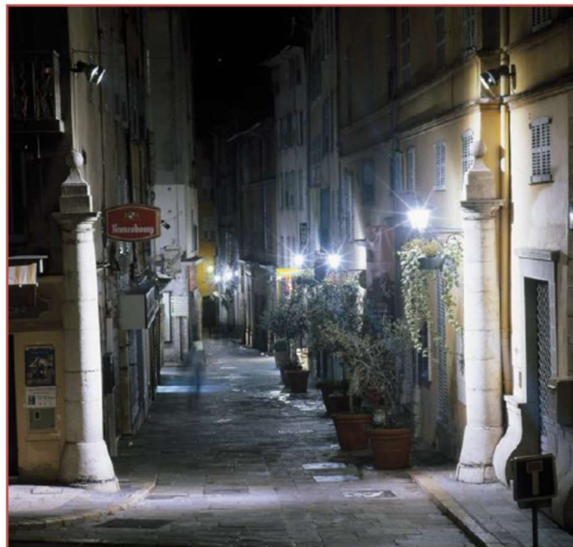
Ulica osvjetljena MH sijalicom (CDO-TT 70W)
