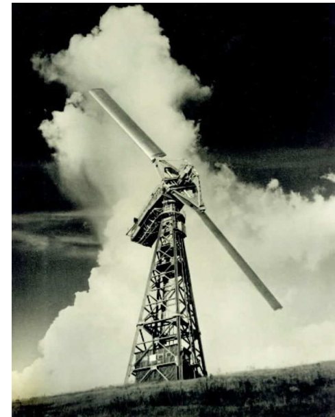
Castelon, Vermont, USA (1941) 1 MW
