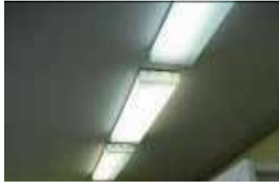
Slika 49: Fluoro lampice sa magnetnom prigušnicom
