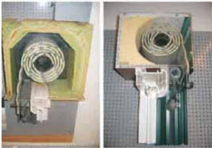
Slika 27: Slika pravilno toplotno izolovane kutije za roletnu
